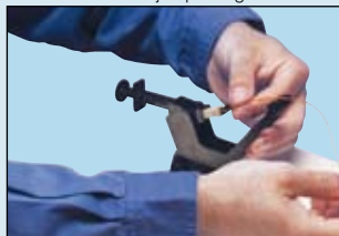
Korak 4: Ubacivanje optičkog vlakna
