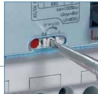
Termomagnetski kompaktni prekidači su podešivi sa prednje strane
